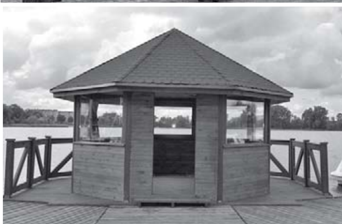
Przebudowa „Bosmanówki” na przystani.
