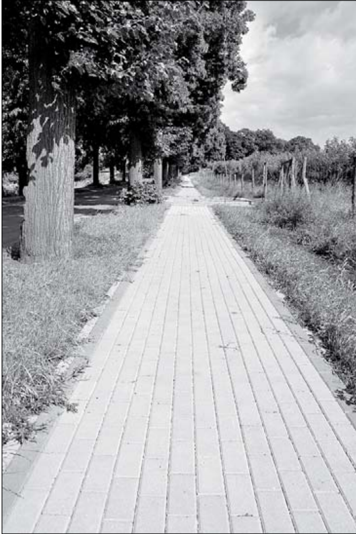
• Budowa chodnika w Otanowie. Wartość zadania 40 tys. zł.
