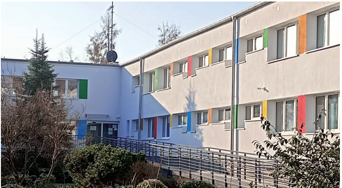
Budynek Regionalnej Placówki Opiekuńczo-Terapeutycznej w Dębnie po termomodernizacji.
