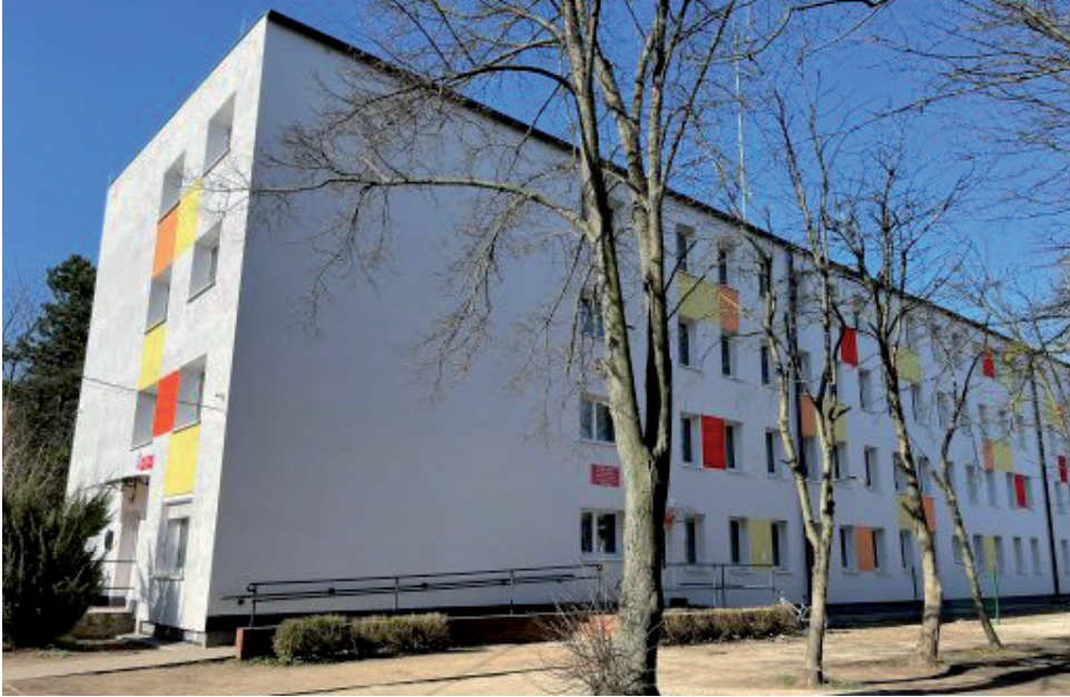
Budynek ZSiPO im. kpt. hm. Andrzeja Romockiego „Morro” w Barlinku po termomodernizacji.
