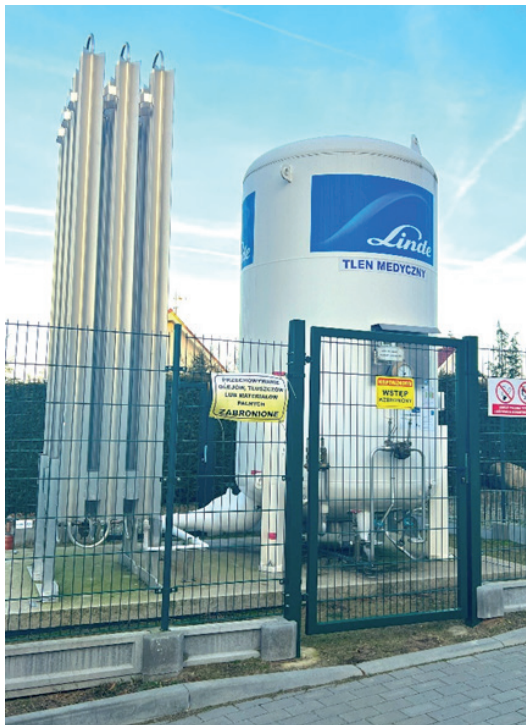
Rozbudowa i przebudowa instalacji tlenu wraz z infrastrukturą techniczną w Szpitalu Barlinek (koszt 332.416 zł).
