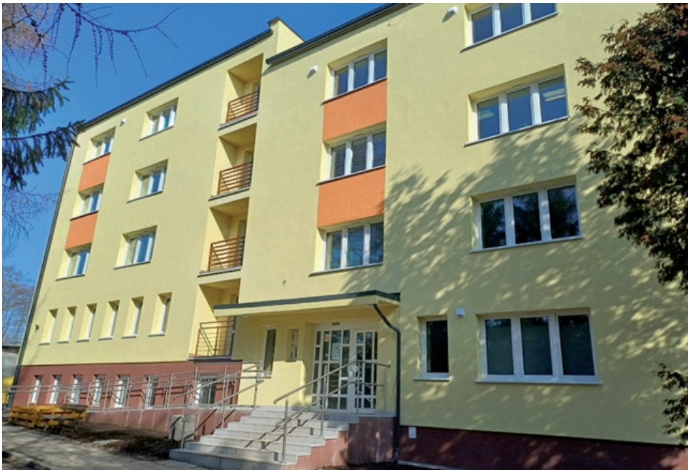
Budynek przy ulicy Spokojnej 13 w Myśliborzu po termomodernizacji.
