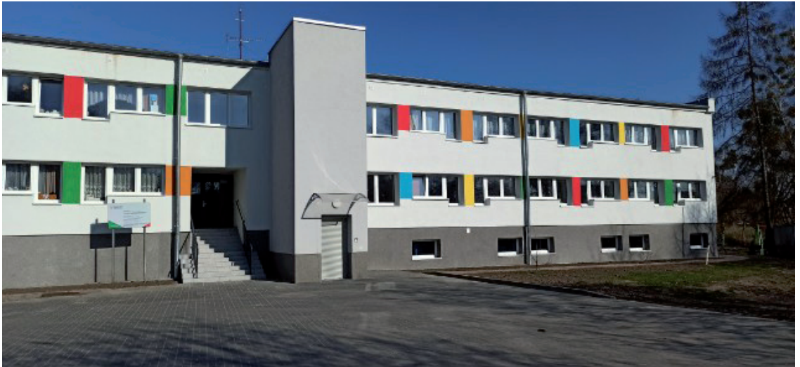
Budynek Regionalnej Placówki Opiekuńczo-Terapeutycznej w Dębnie po modernizacji widok od strony parkingu.
