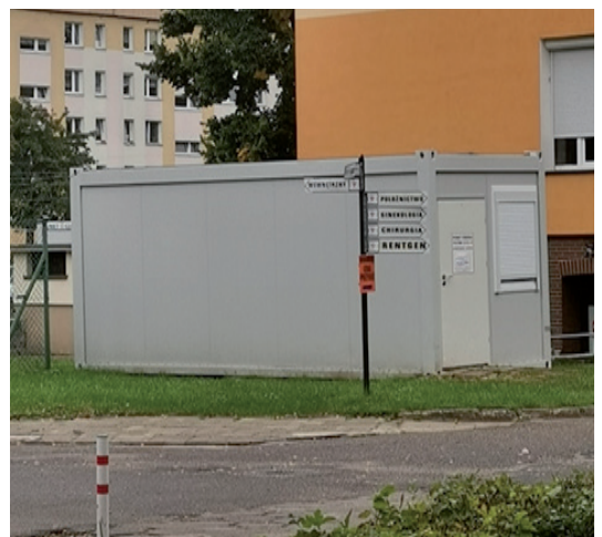
Punkt szczepień oraz punkt pobrań w zabudowie kontenerowej w Szpitalu Dębno.
